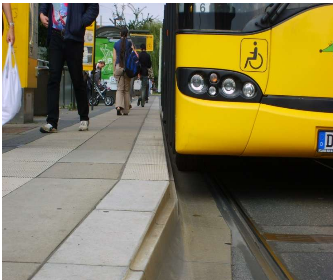
Fot. 15.4.1.3. Zalecane ukształtowanie krawędzi peronowej. Źródło: materiały własne TRAKO.
